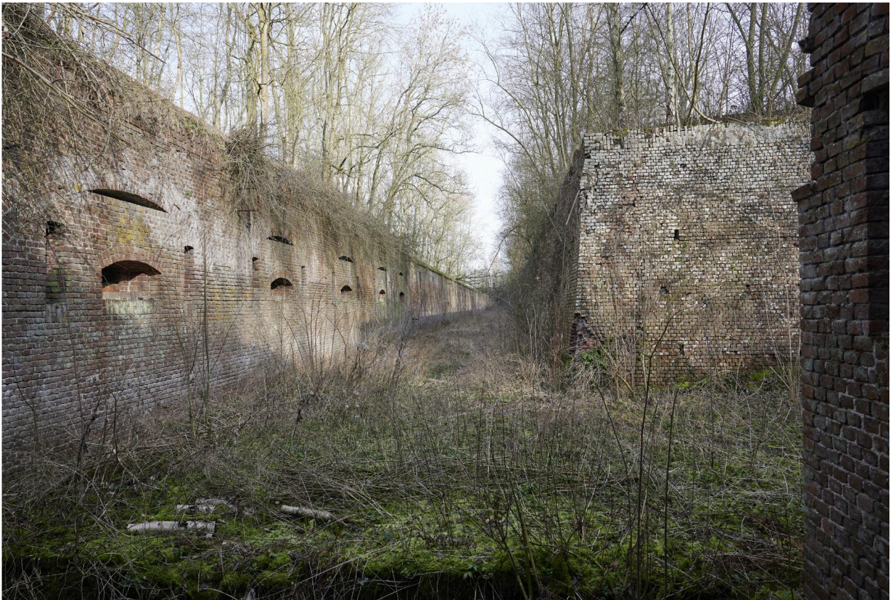
Galerie de fusillade et fossé est, vers le nord depuis la caponnière double.
