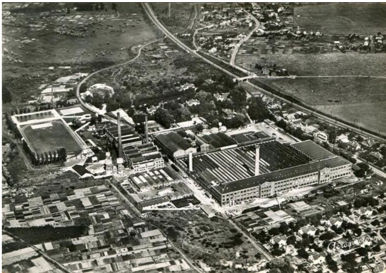
Vue générale des usines textile de Gauchy, avec dans le coin en bas à droite la cité ouvrière, et en haut à gauche, le stade et la piscine, carte postale, vers 1950 (coll. part.).
