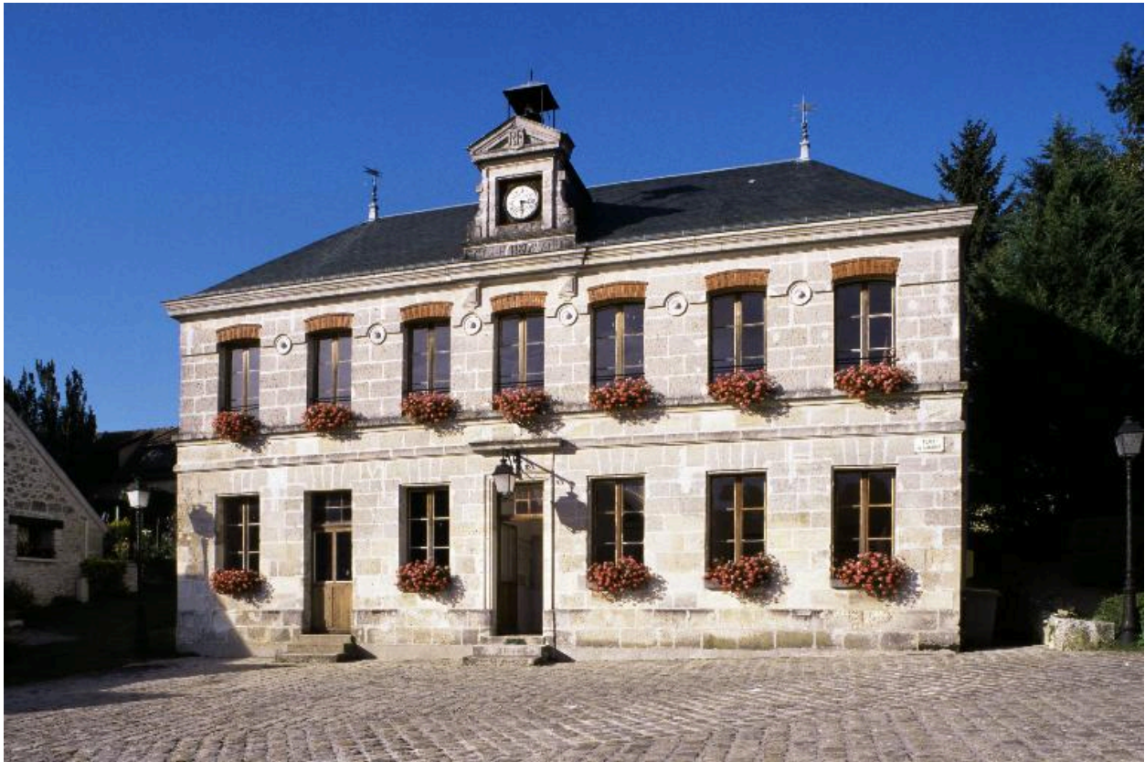
Vue de la façade.
