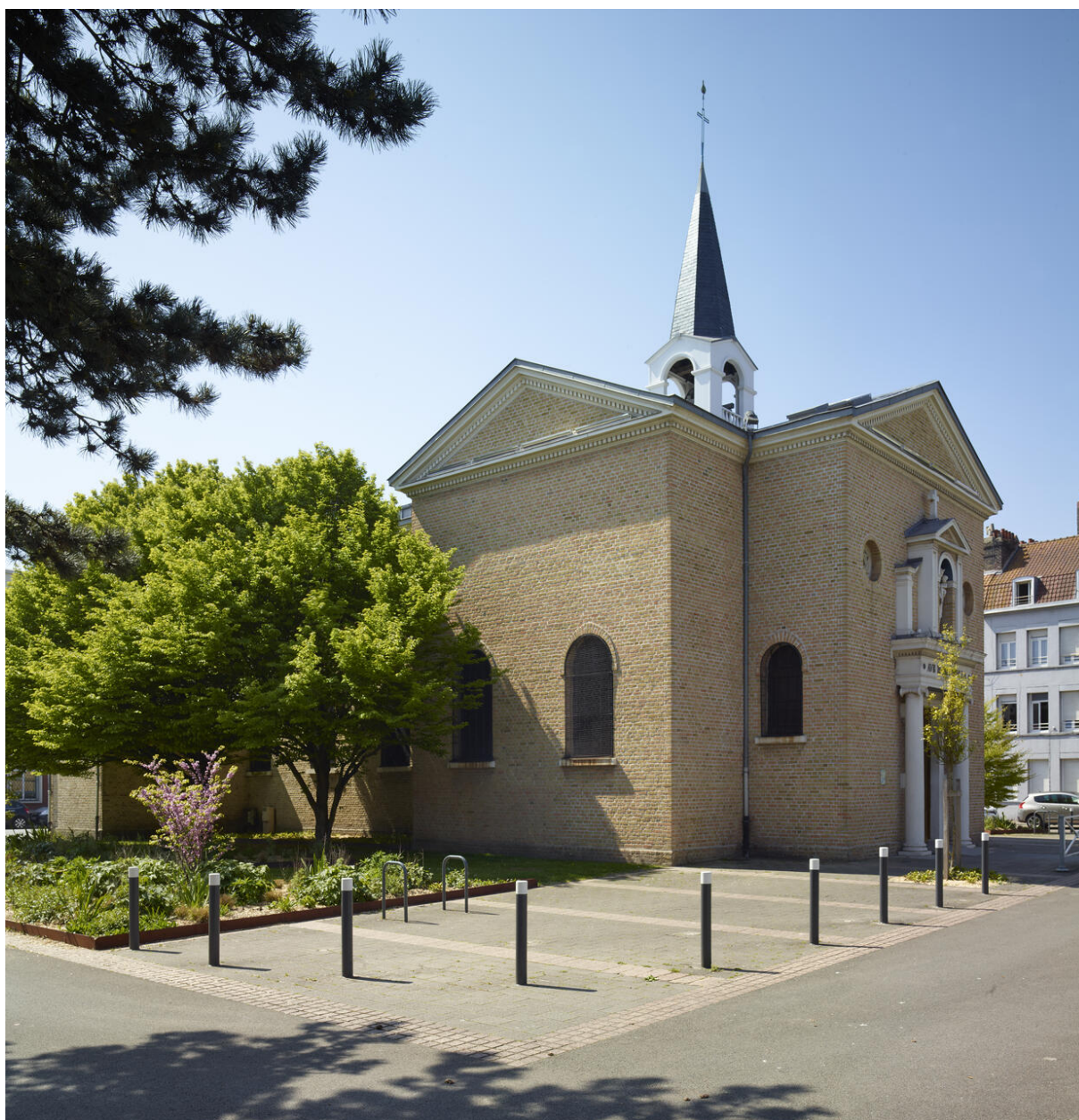
Vue générale de trois quarts depuis le nord-est.
