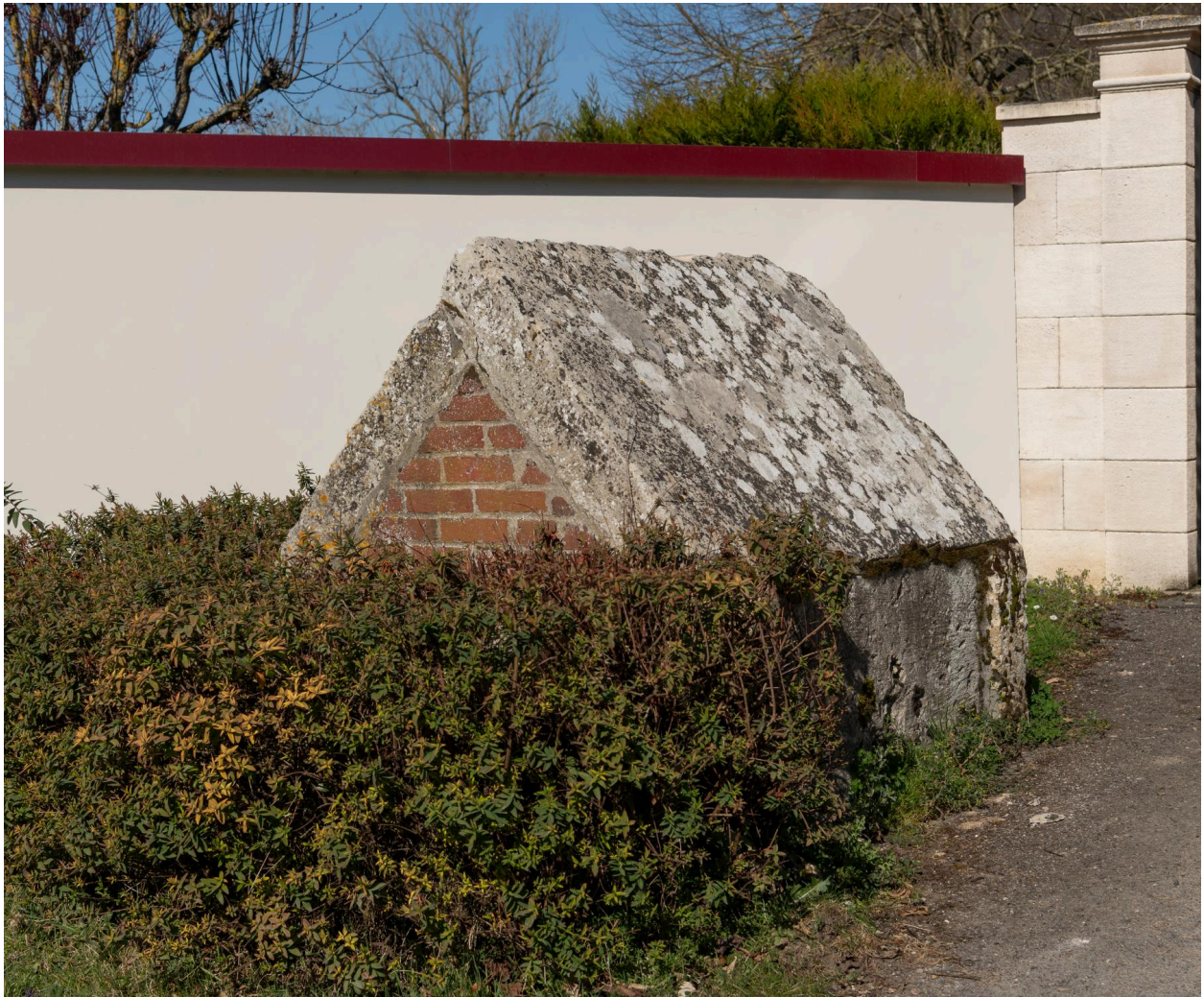
Ancien puits de la rue du Puits-Revel, vue depuis le sud-est.
