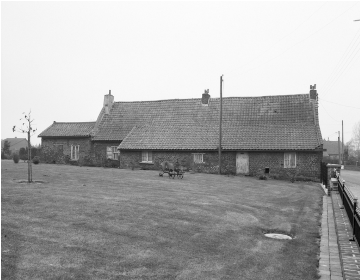
Vue générale de la façade postérieure du logis.
