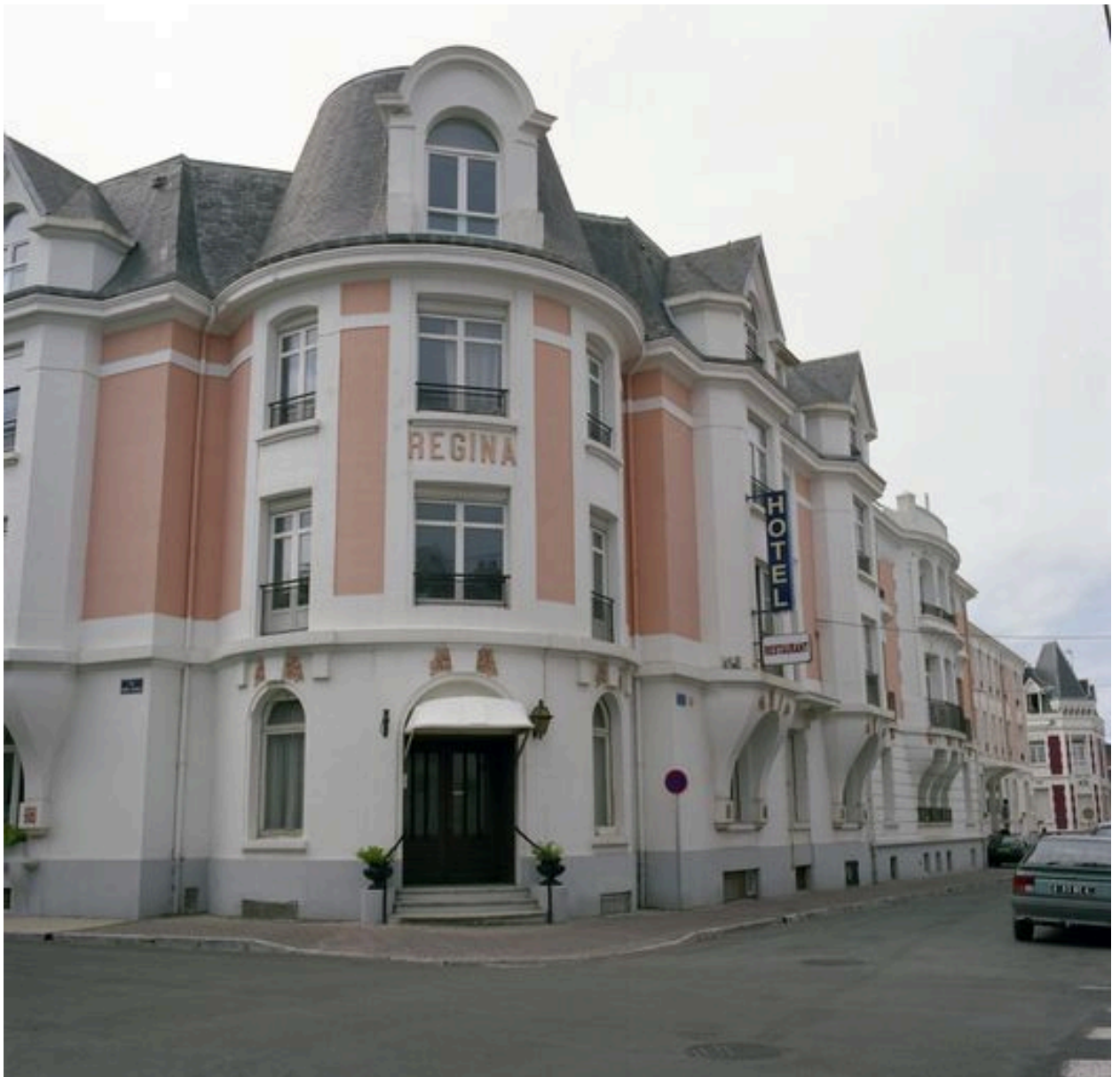
Elévations sur les rues de Lhomel et Eugène-Trigoulet, vue angulaire montrant l'enfilade des façades donnant sur la rue de Lhomel.
