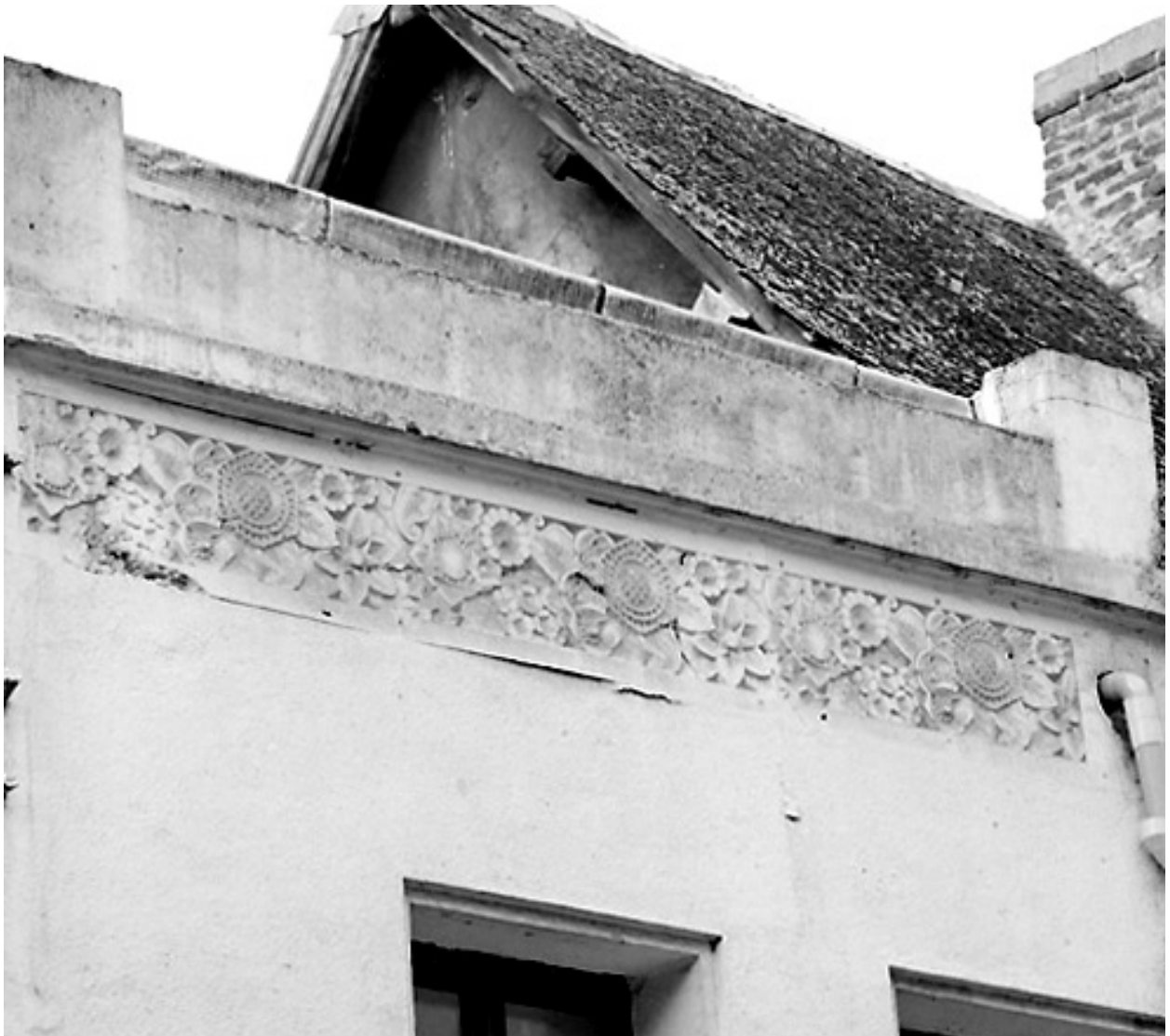
Façade du n° 12, détail : frise en ciment moulé située sous la corniche.
