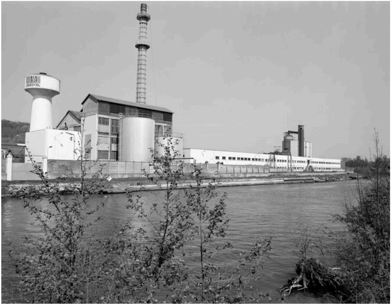
Ateliers de fabrication : vue générale, flanc est.
