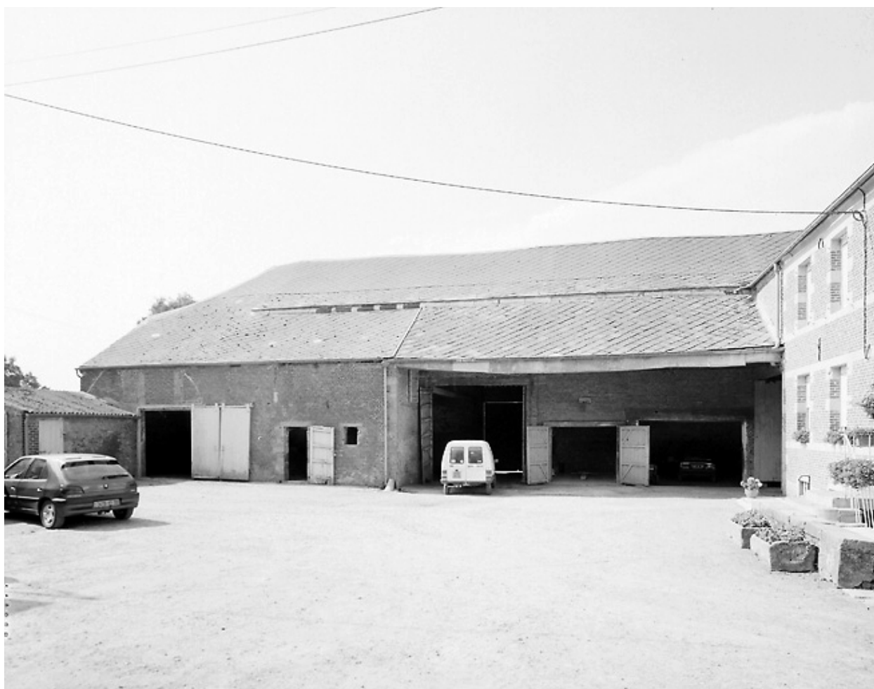
Vue des bâtiments d'exploitation de l'aile sud.
