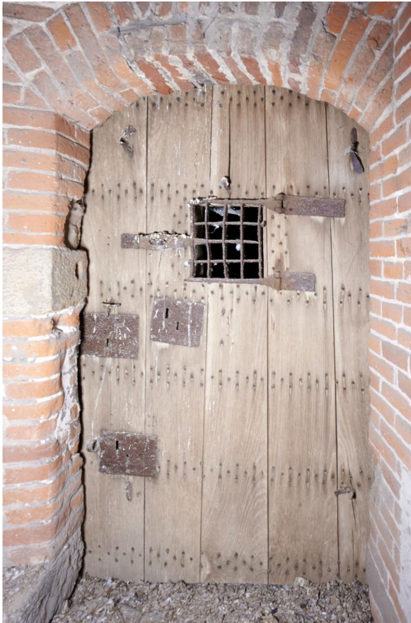
Niveau principal (R+1). Vue de la porte d'accès à la salle depuis la tour d'escalier. Porte à guichet.
