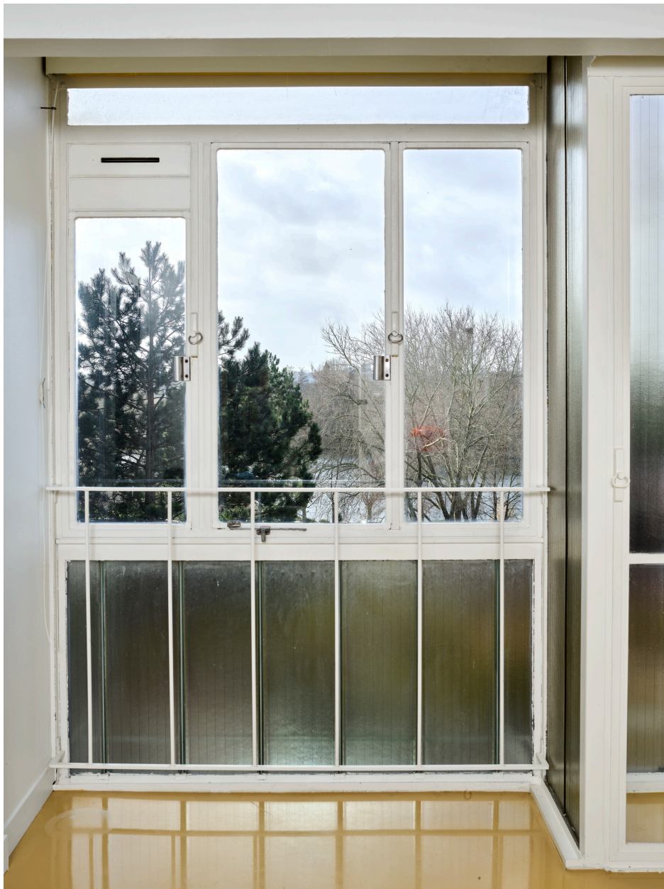
Baie du séjour avec profilés en acier et un garde-corps d'origine.
