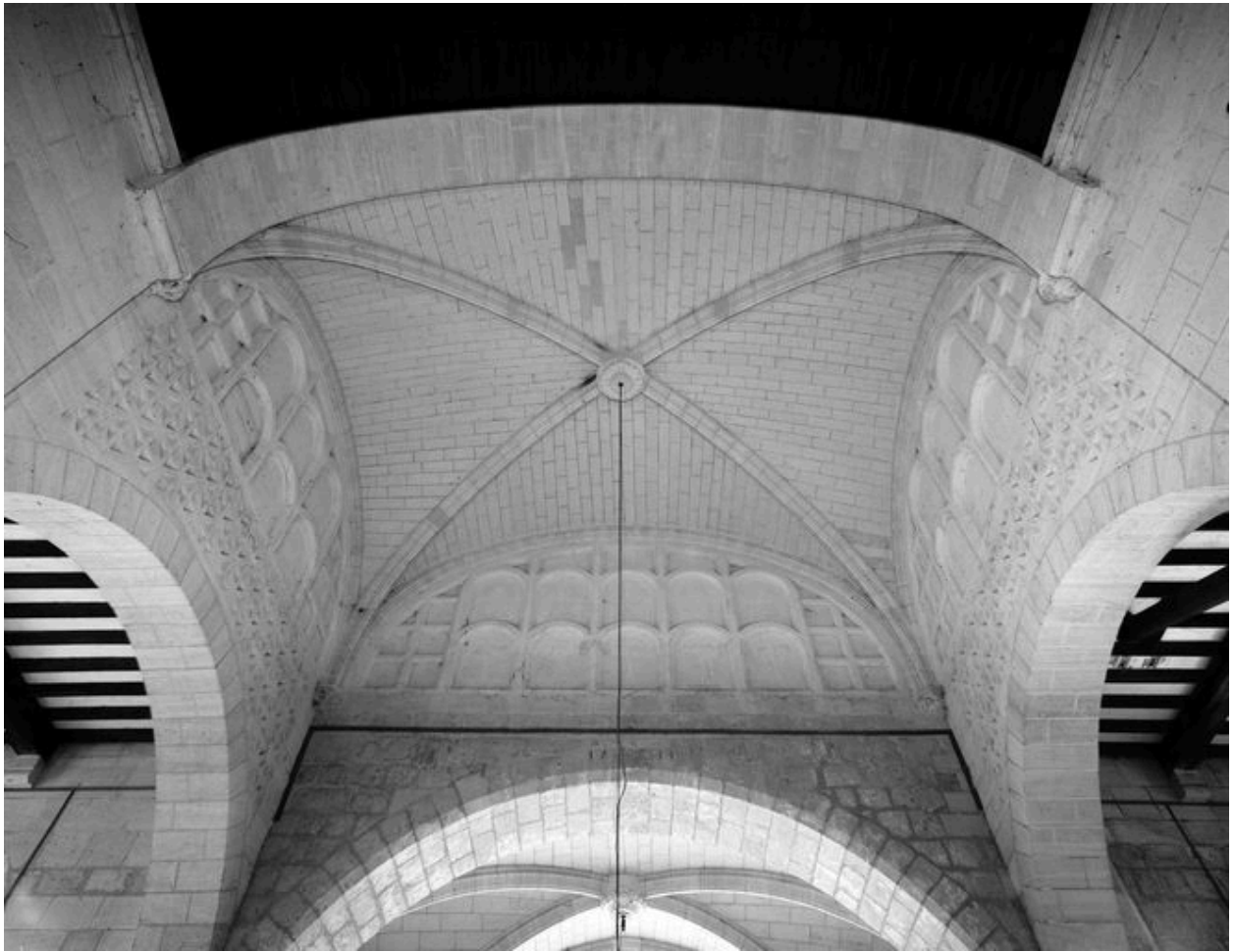
Voûte de la croisée du transept.
