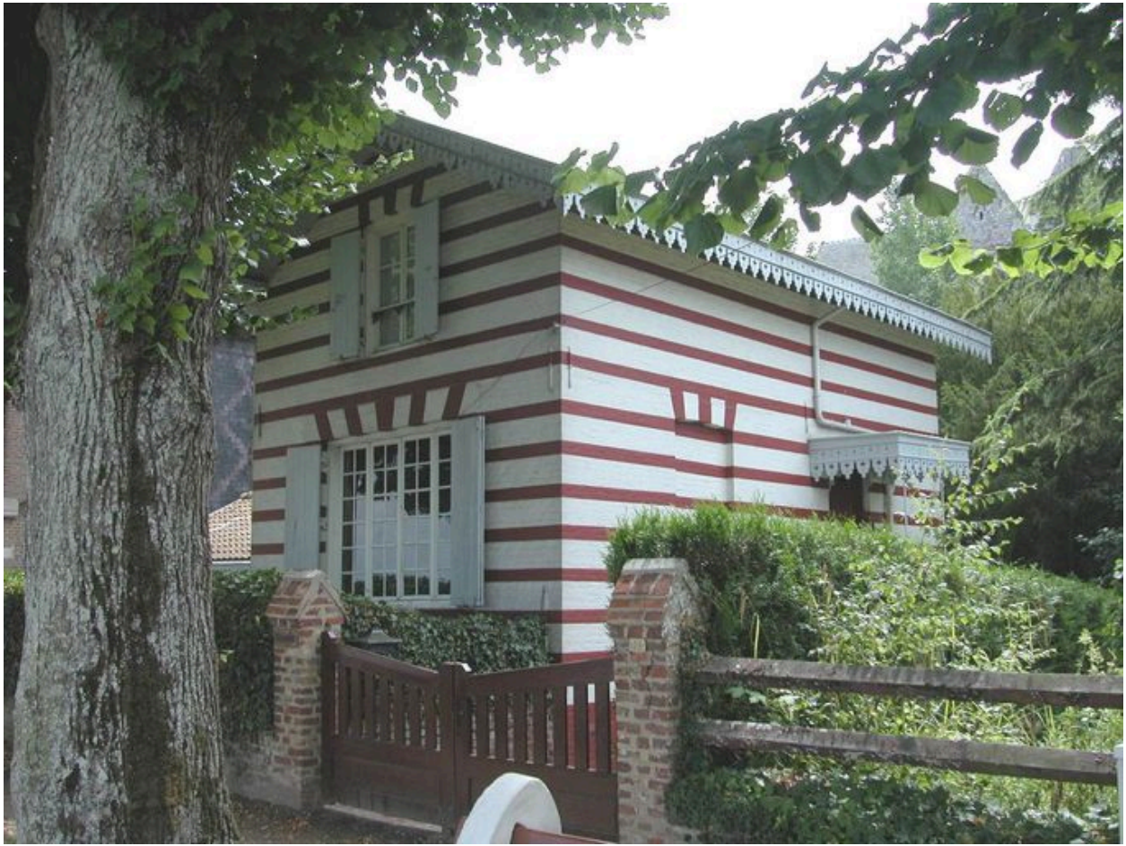
Vue d'ensemble depuis la digue.
