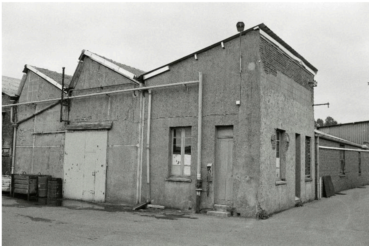
Les ateliers de fabrication, en 1990.
