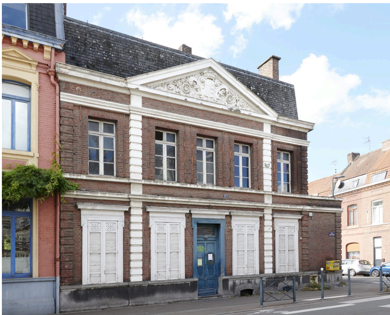
Vue générale de la façade.
