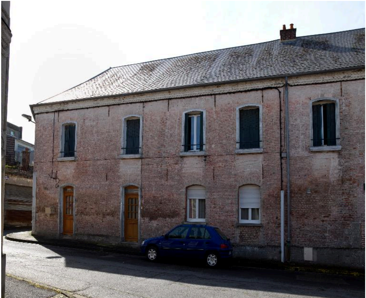
Vue de la façade sud.
