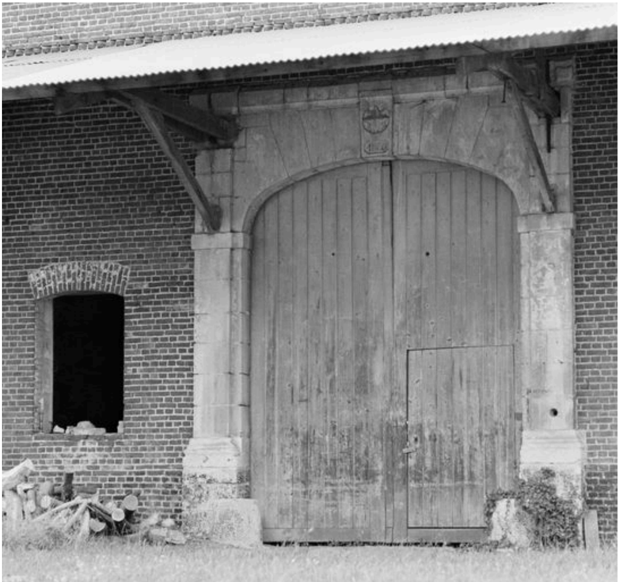
Atelier de fabrication : portail portant la date 1860.
