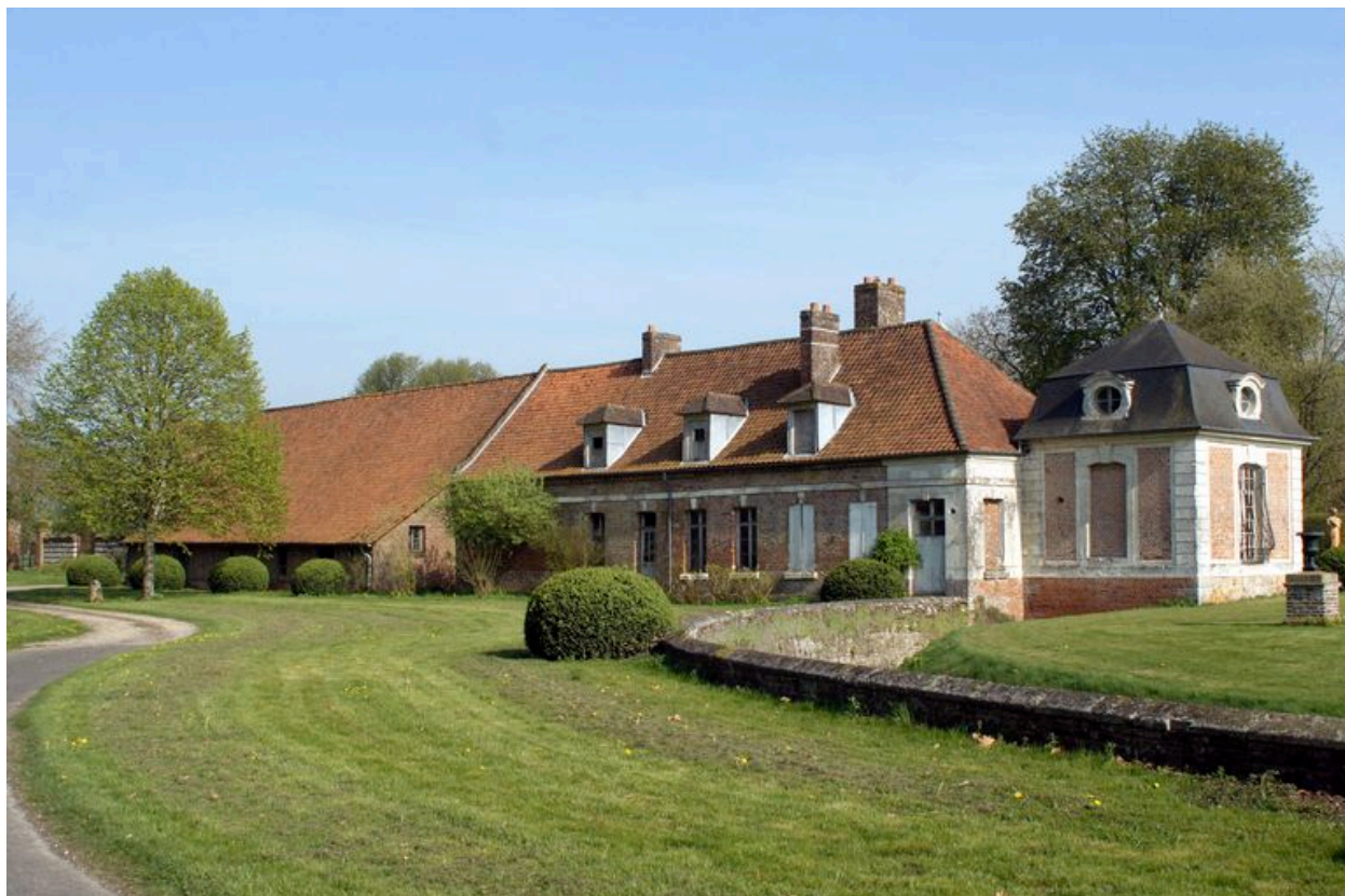
Vue extérieure des communs depuis l'esplanade.
