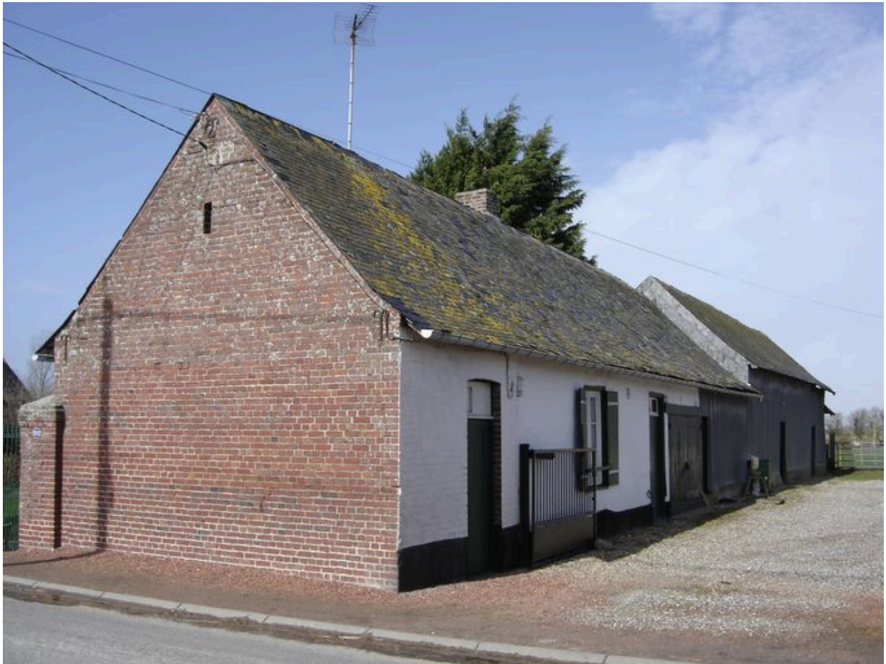
Vue de la bergerie au fond de la cour, à l'origine en torchis et pans de bois.
