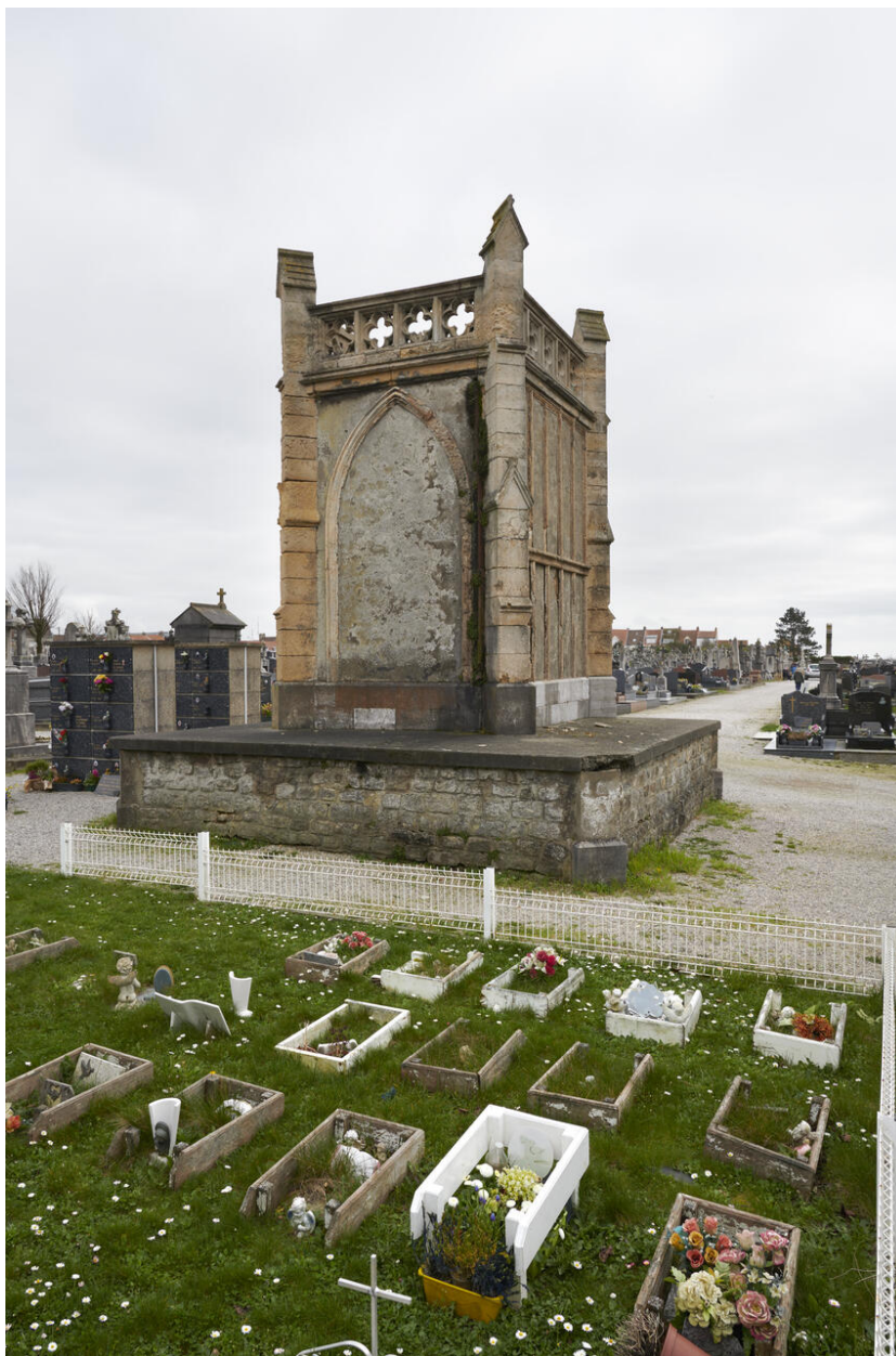
Vue de la façade nord.
