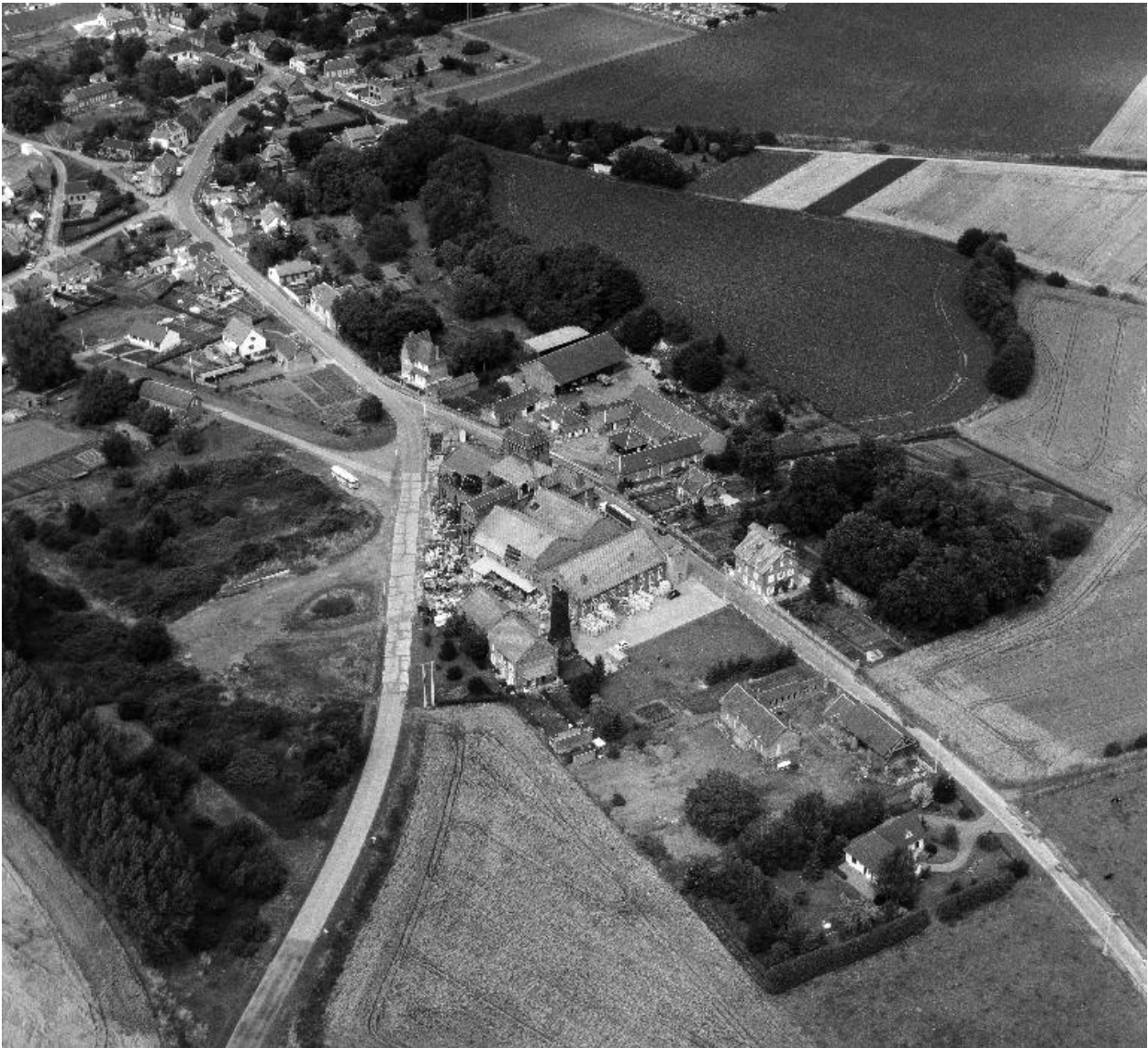
Vue aérienne, flanc sud-ouest.
