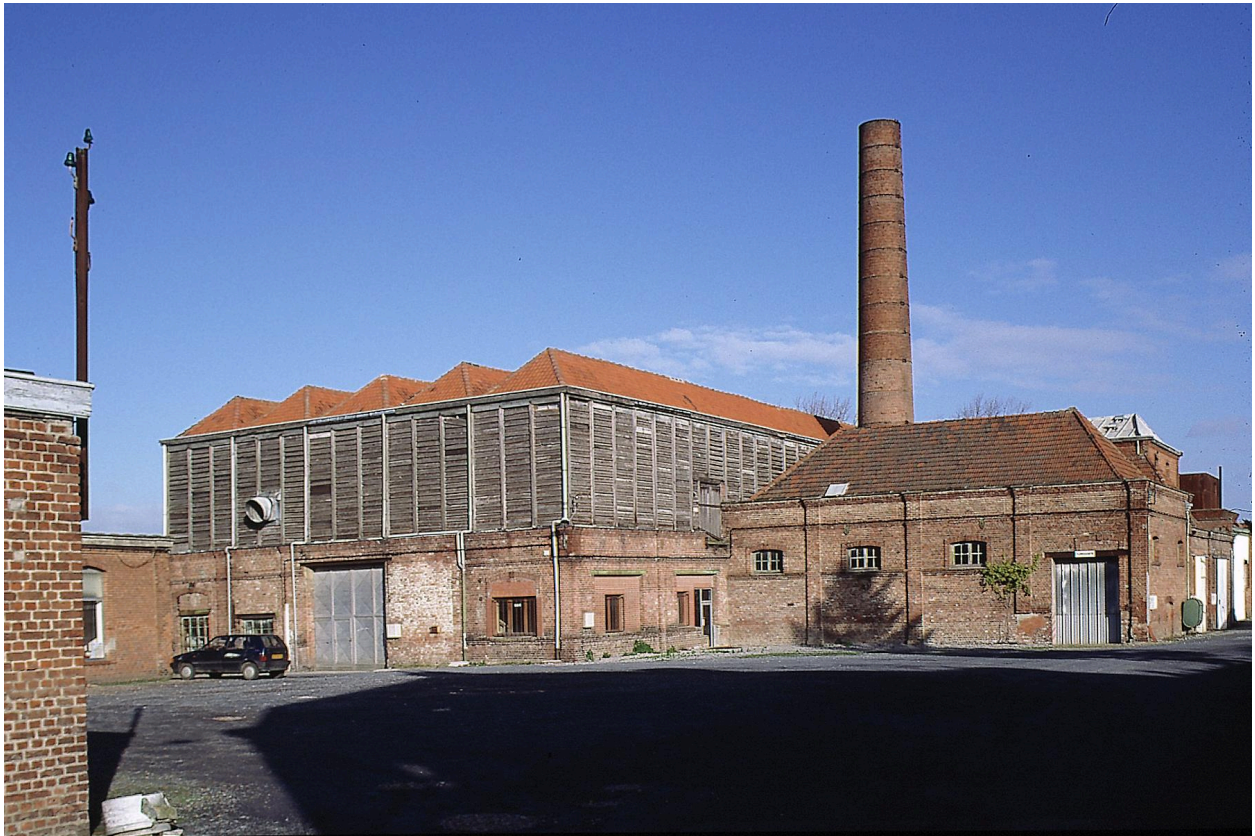
Vue générale de l'usine vers le nord, depuis le portail d'entrée.
