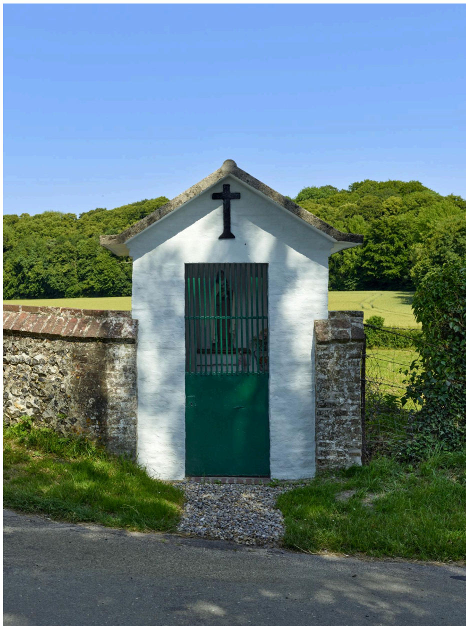
Chapelle, rue de Vercourt.
