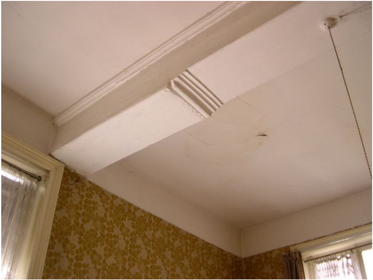
Intérieur, premier étage, pièce sud-ouest : plafond, vue partielle, about de poutre mouluré.
