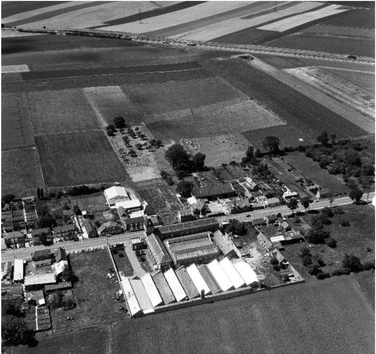
Vue aérienne, flanc est.
