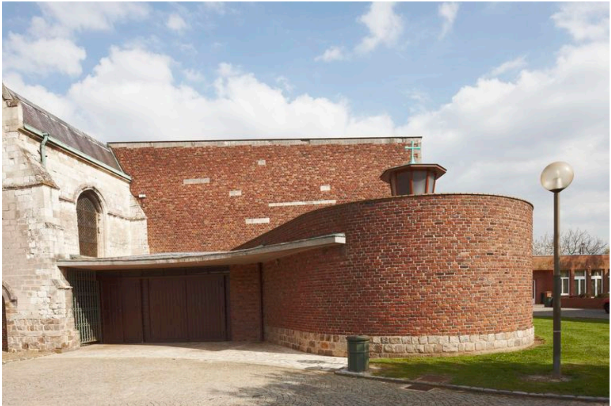
Détail de l'entrée et du baptistère.
