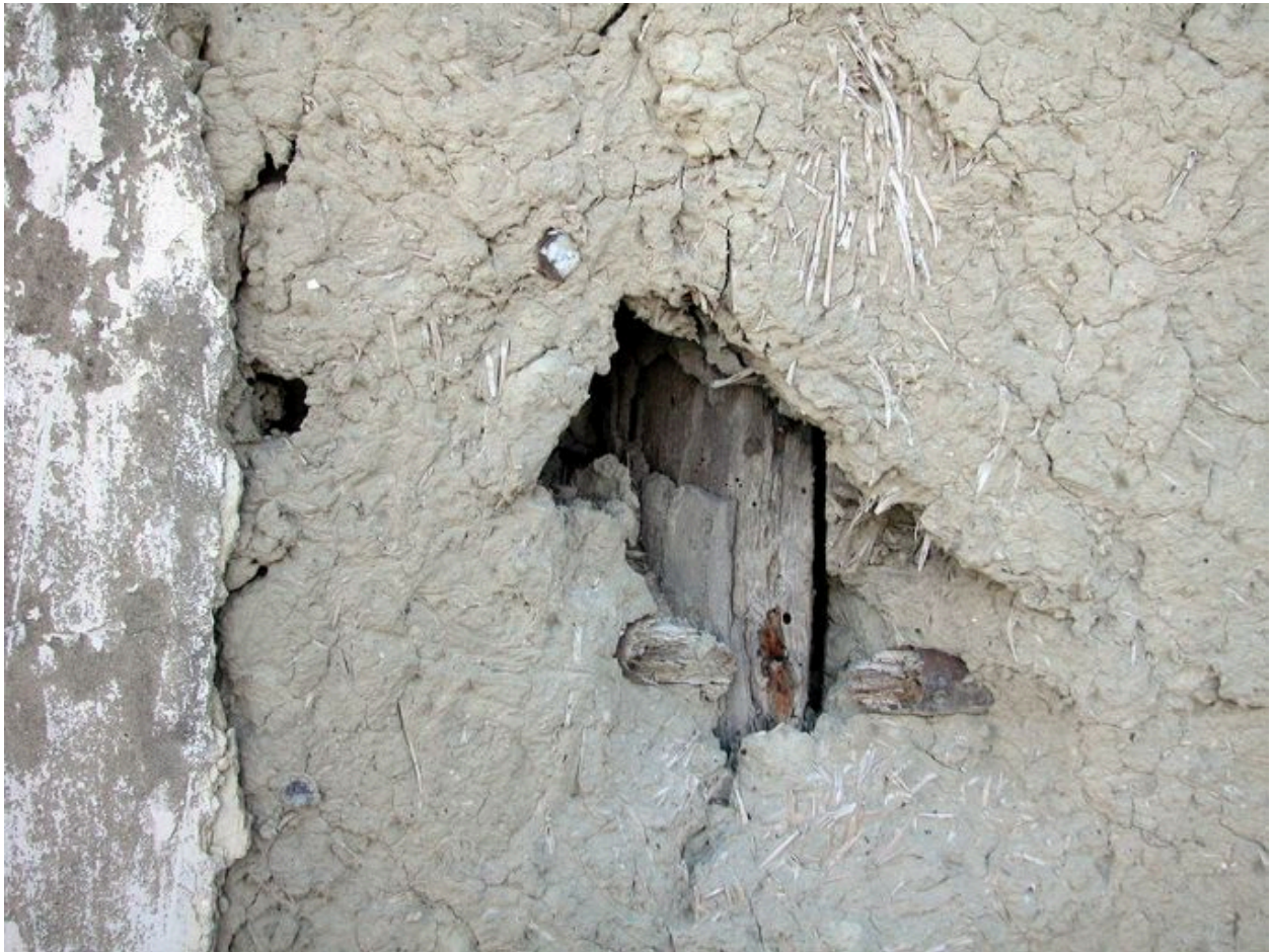
Détail du mur de la maison 14 rue d'Enfer.
