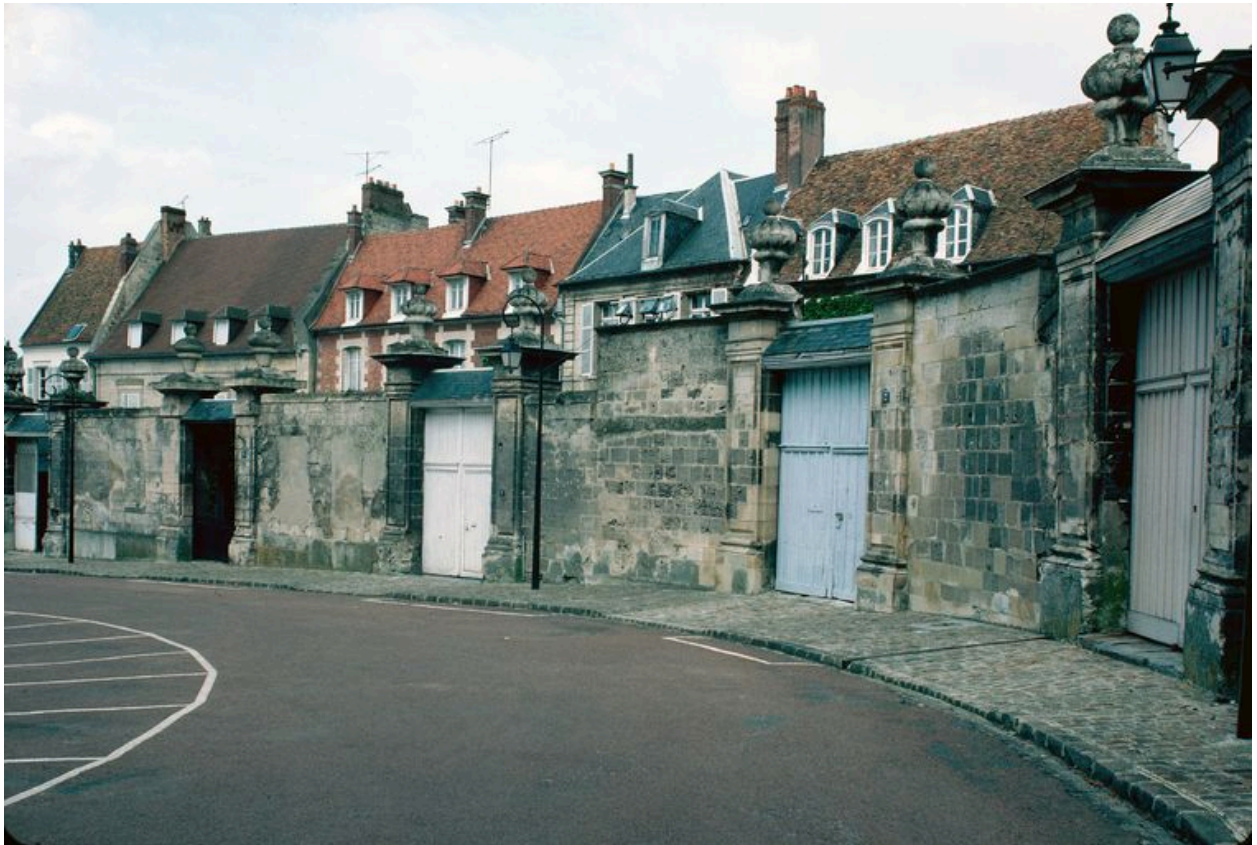
Vue de l'enfilade des portails des maisons de chanoines de la place du Parvis.
