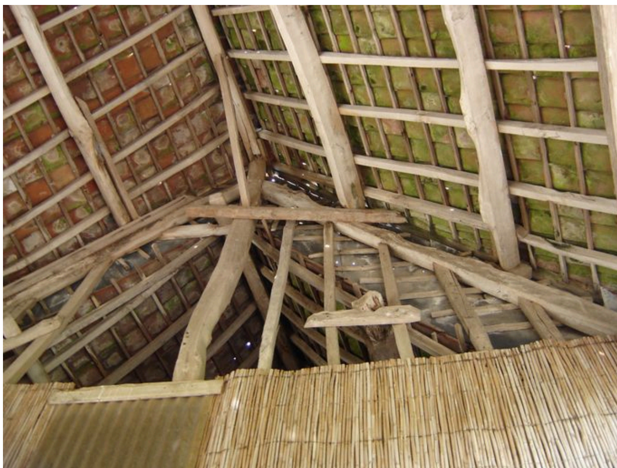
Vue de la charpente du passage couvert.
