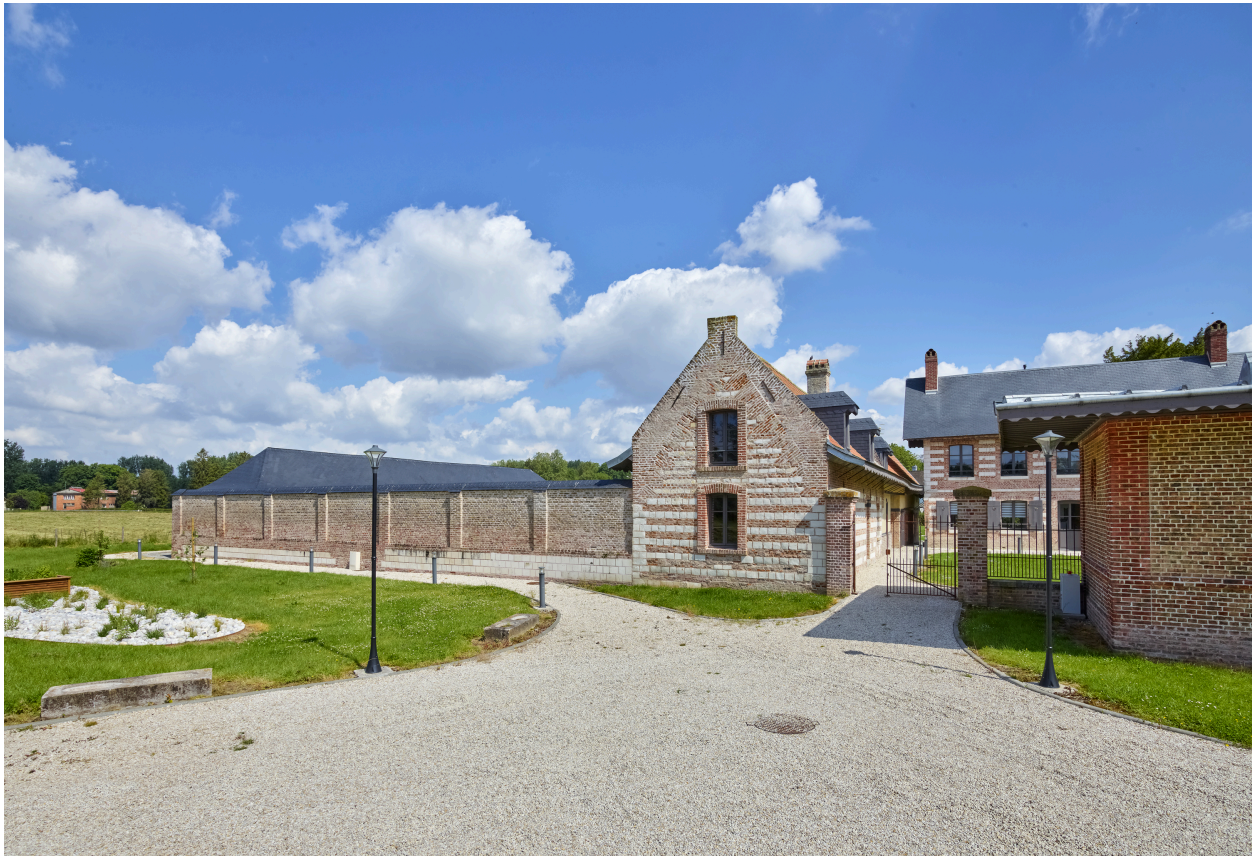
Mur-pignon du bâtiment ouest et mur de clôture de l'ancien potager.
