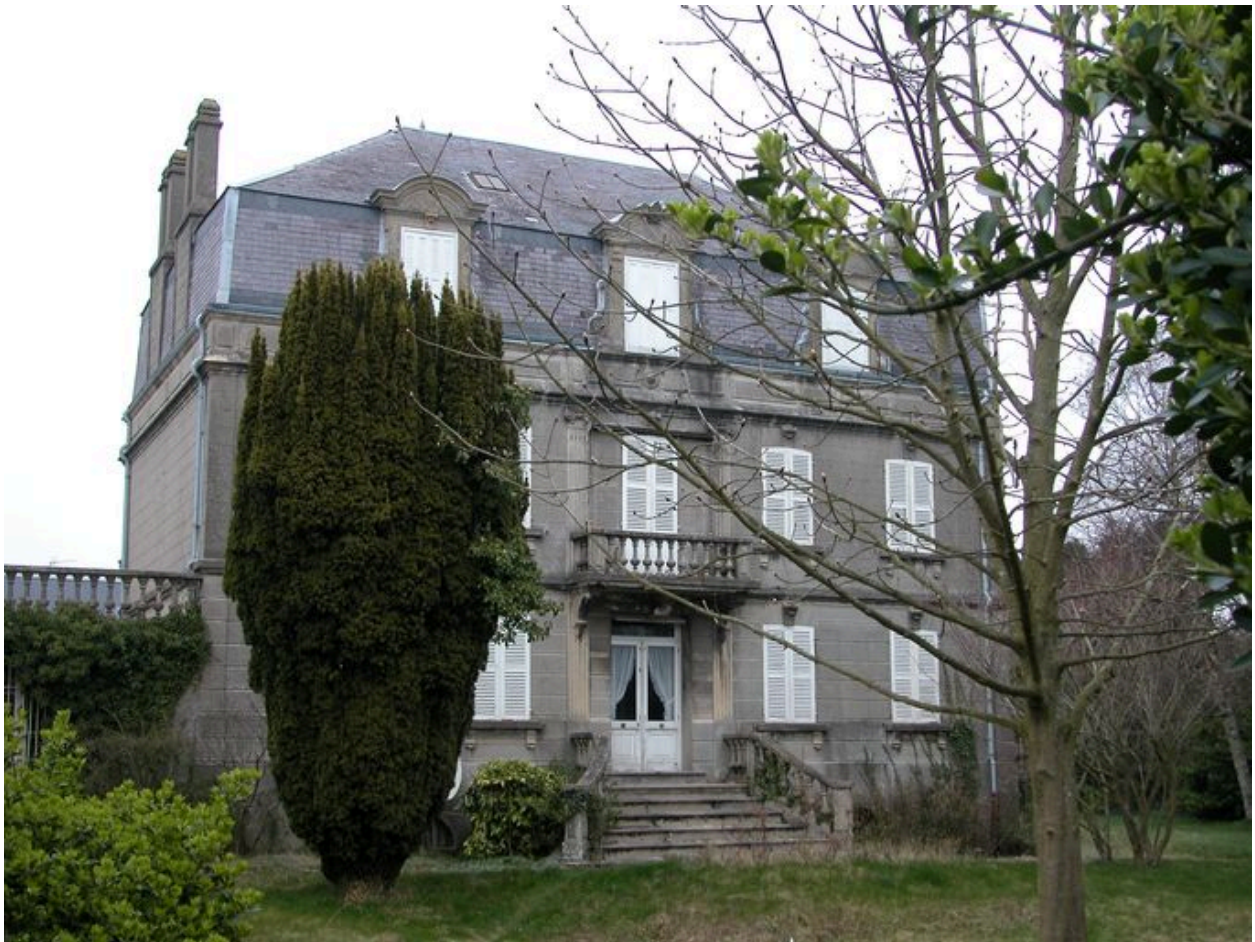
Elévation antérieure, vue rapprochée.
