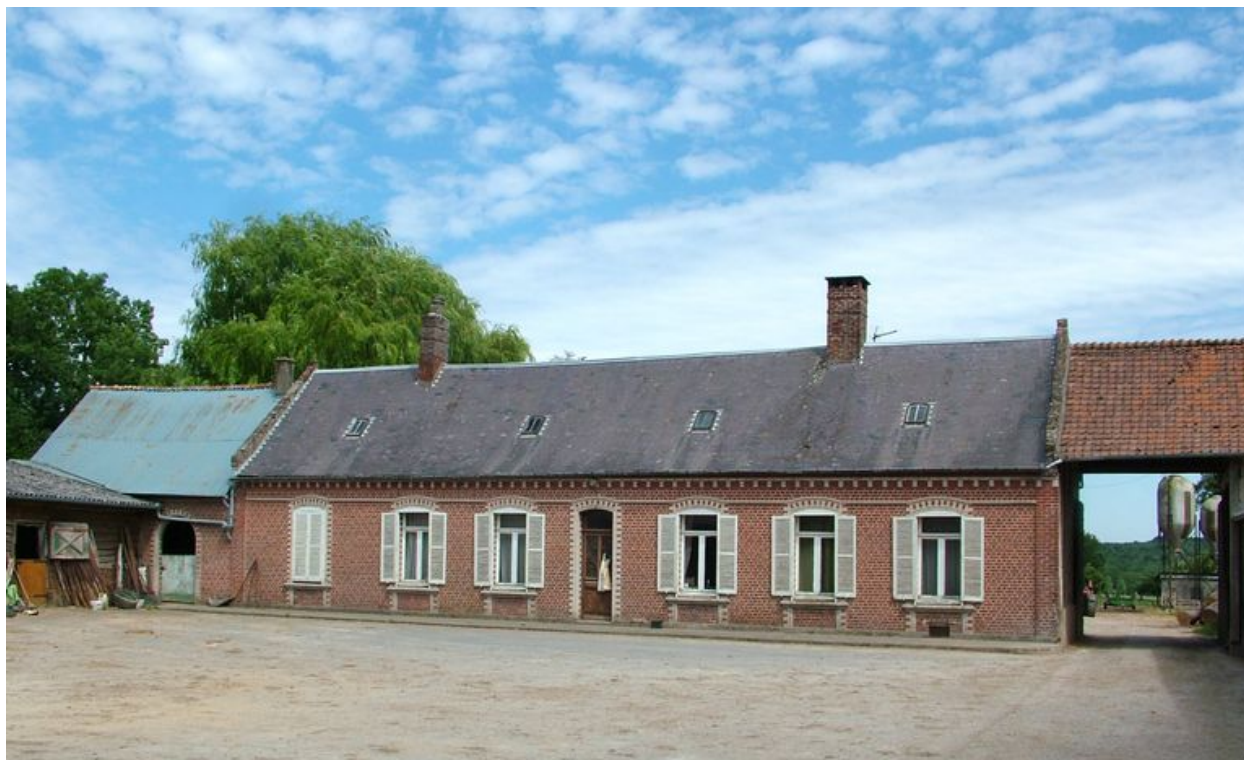
Fransu, logis de ferme, 10 Grande-Rue, portant la date de 1792 mais reconstruit au milieu du 19e siècle.
