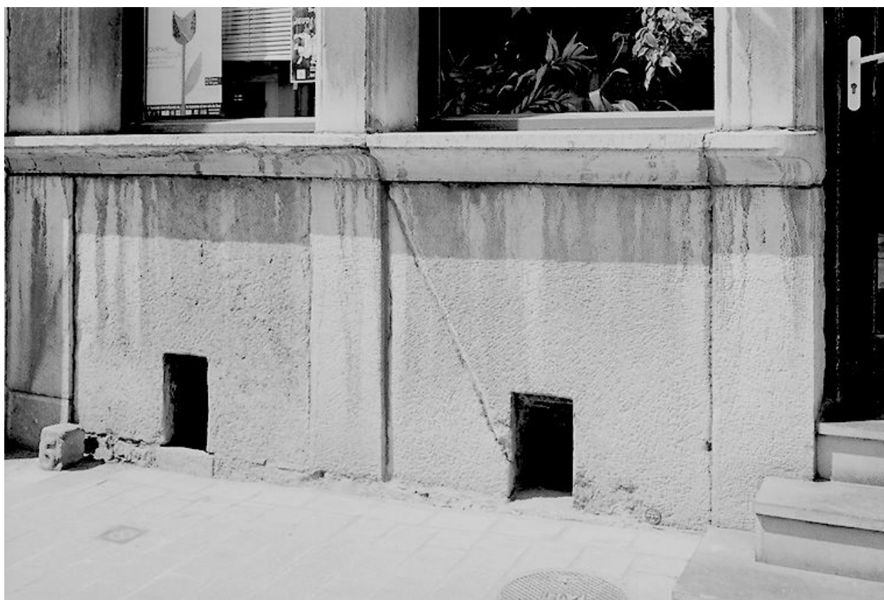
Façade, détail : soubassement et appuis de fenêtres du rez-de-chaussée ; on note l'emploi d'éléments monolithes et les traces d'outils.
