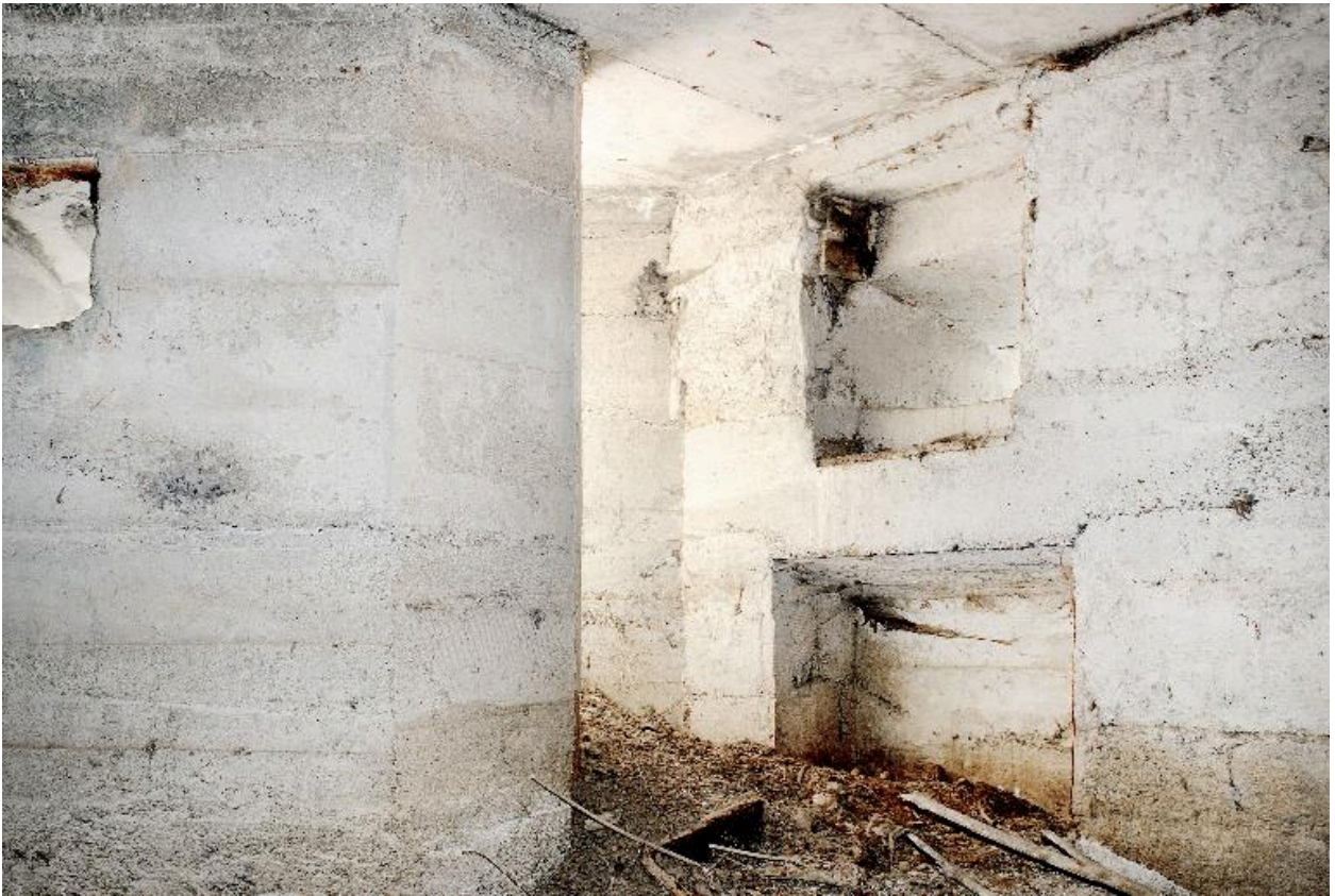
Entrée sud, le créneau de fusillade à gauche (au grand angulaire)
