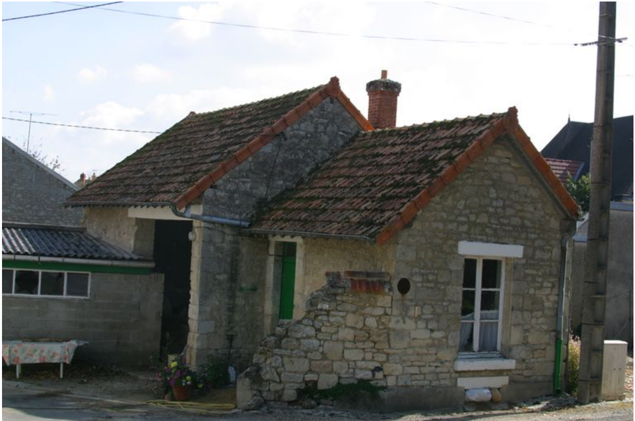
Vue de la remise.
