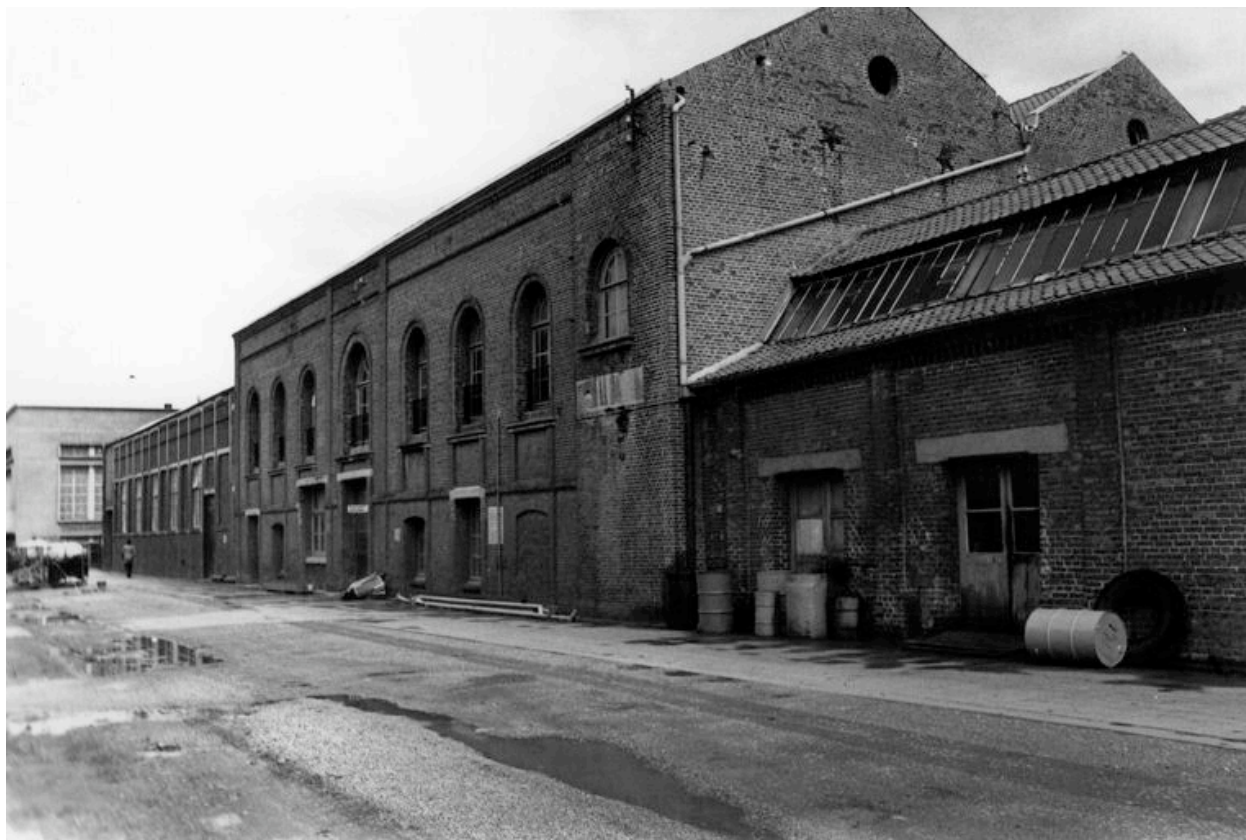
Salle des machines, en 1983 : élévation nord (Ecomusée du Beauvaisis).
