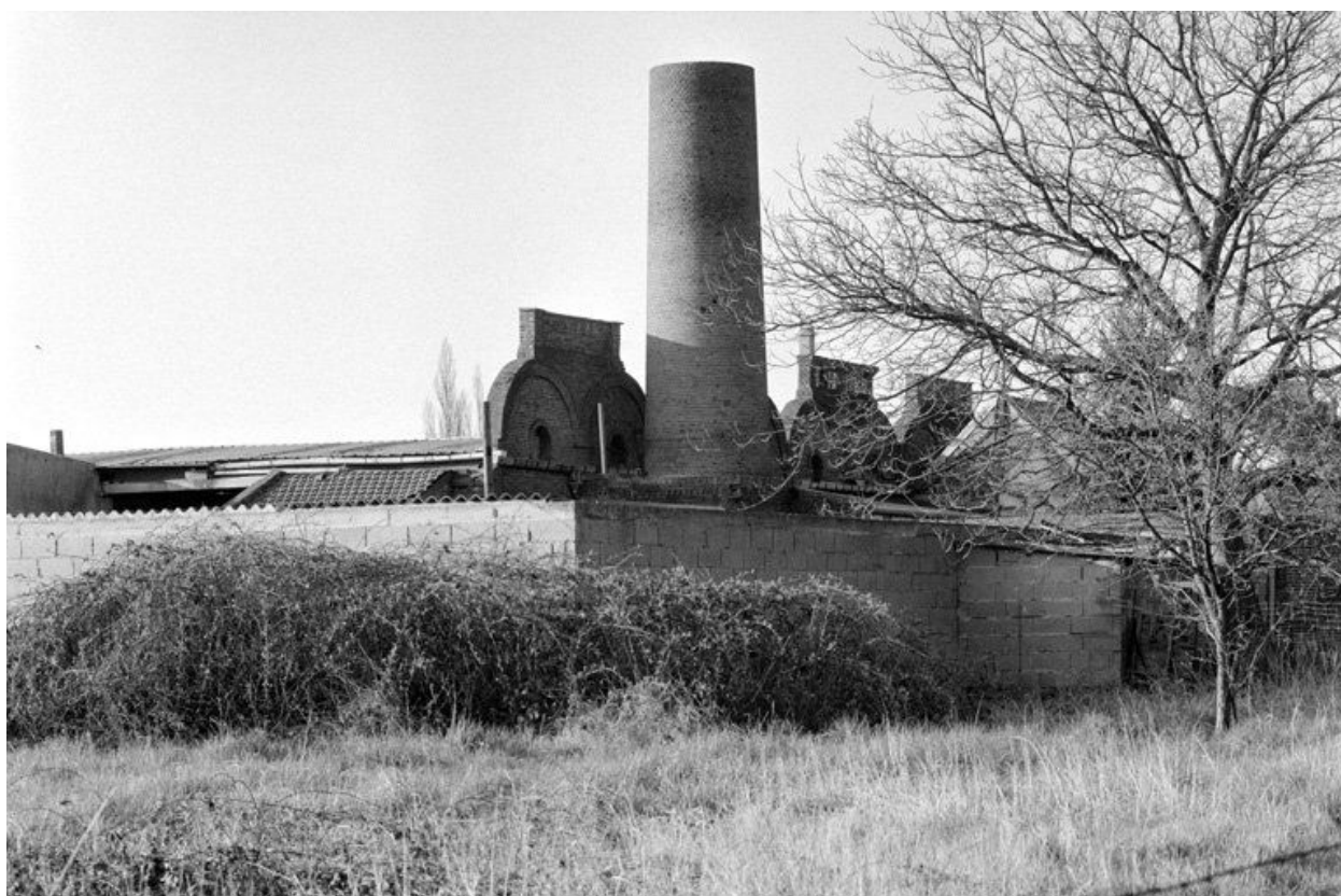
Atelier de fabrication, vue partielle du flanc ouest.
