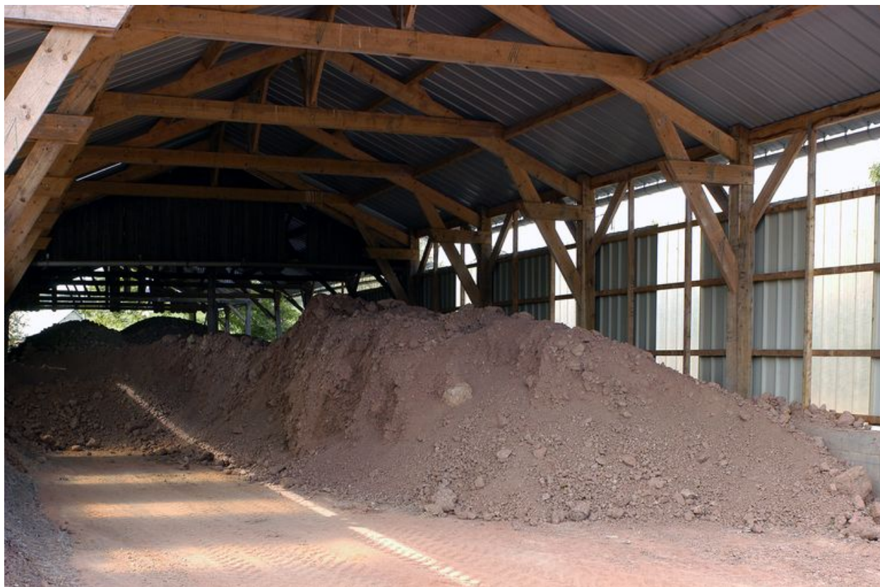
Hangar d'entrepôt à terres.
