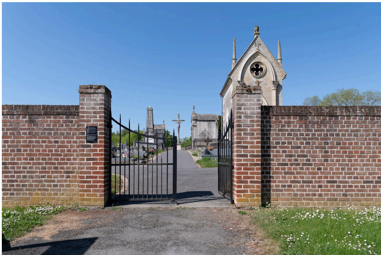
Vue générale de l'entrée du cimetière.
