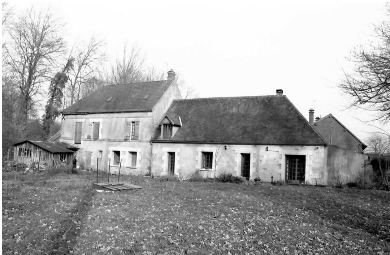
Ancien moulin en pierre datant du début du 19e siècle, transformé actuellement en logement, vue d'ensemble de la façade postérieure.
