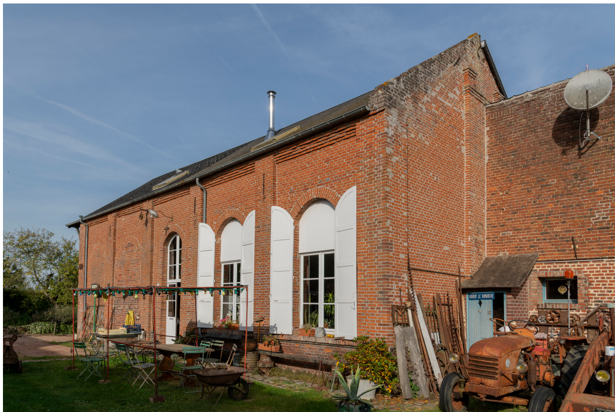
Ancien atelier, vue depuis le sud-est.
