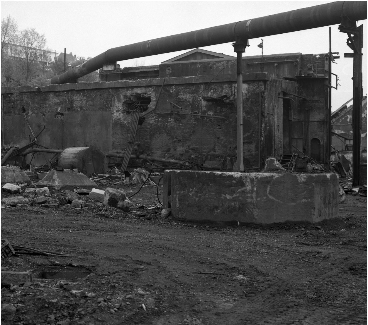
Compresseur, redresseur : façade sud.
