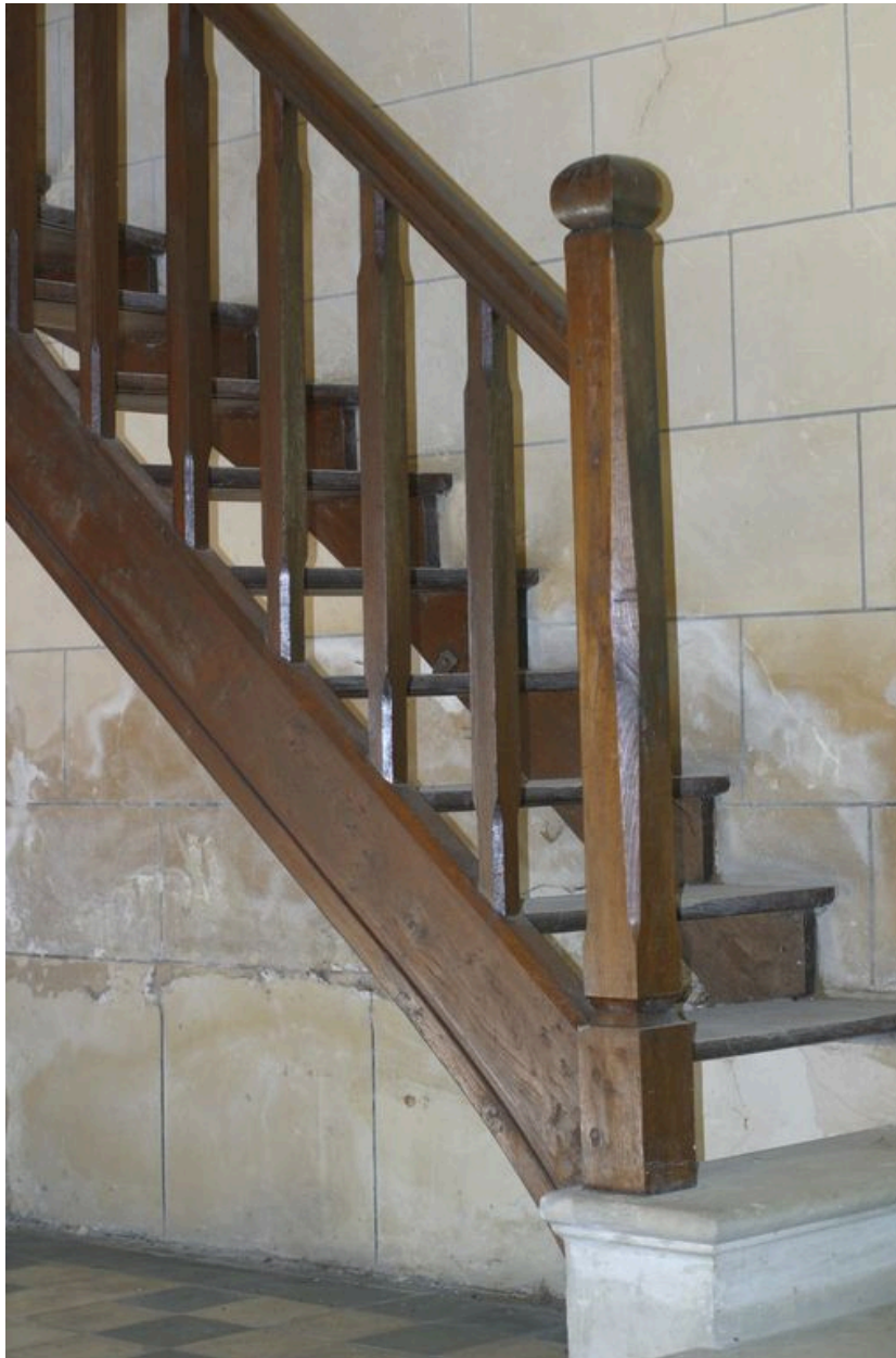
Vue de l'escalier en chêne menant à la tribune.
