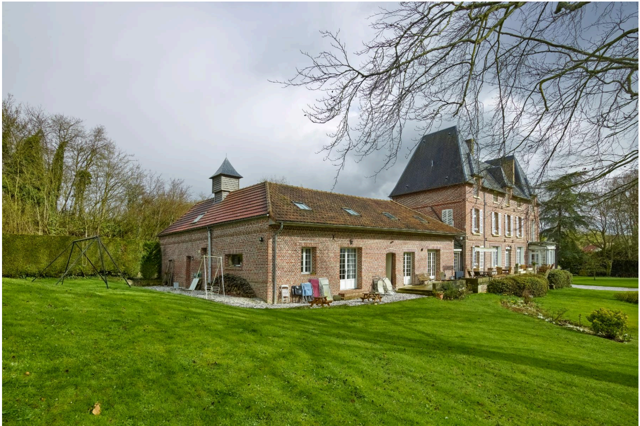
Vue de la dépendances et de la demeure, depuis l'ouest.
