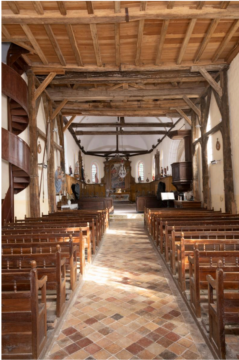
Vue intérieure vers le chœur.
