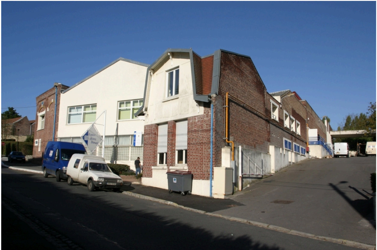
Vue générale de l'usine.
