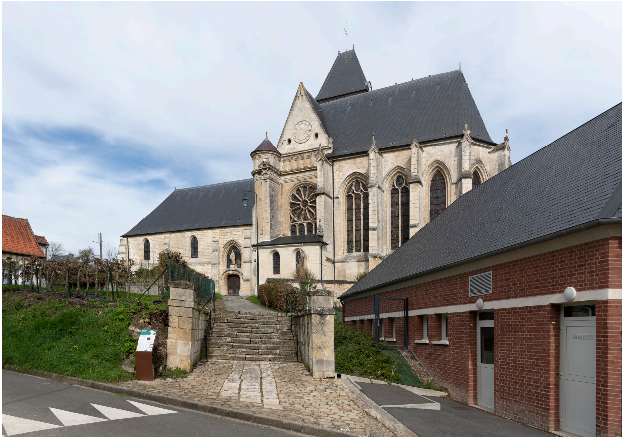
Vue prise depuis la rue de l'Église au sud.
