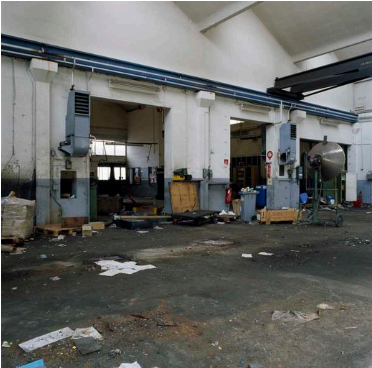
Anciens ateliers de maintenance.
