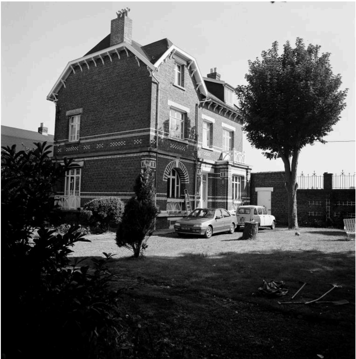
Logement patronal. Vue prise vers le nord.
